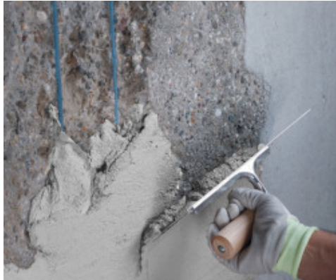
Aanbrengen van Planitop Rasa & Ripara Zero met een spaan
