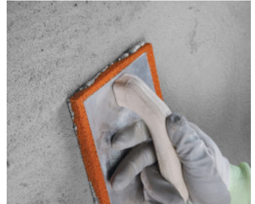
Aanstampen van Planitop Rasa & Ripara Zero
