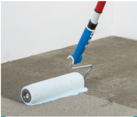
Aanbrengen van de primer op de ondergrond
