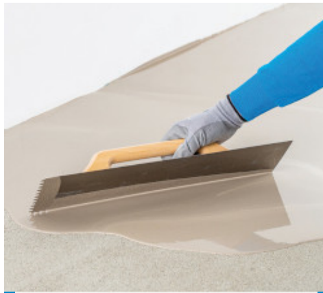
Aanbrengen van Ultraplan Contract
