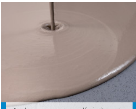
Aanbrengen van een zelf-nivellerend egalisatiemiddel op een droge laag Eco Prim Grip Plus op een bestaande vloer
